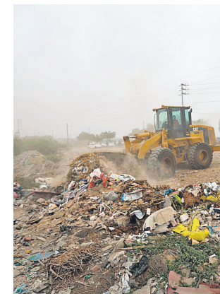
Recogen 600 m3 de residuos.
