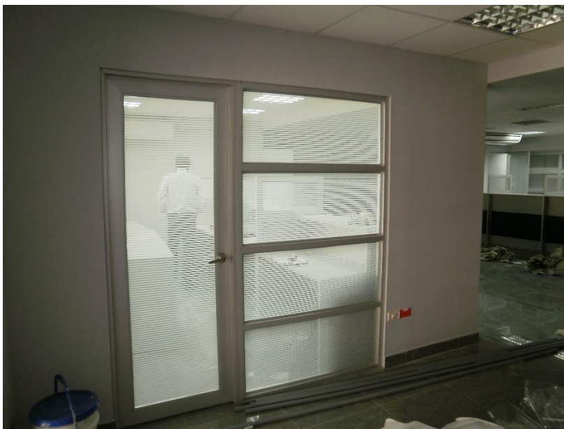
Imagen 06. Vista referencial tabiquería de aluminio y vidrio.
