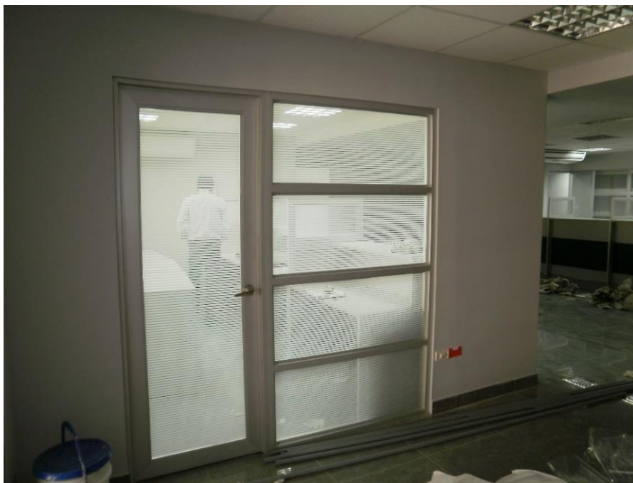
Imagen 06. Vista referencial tabiquería de aluminio y vidrio.
