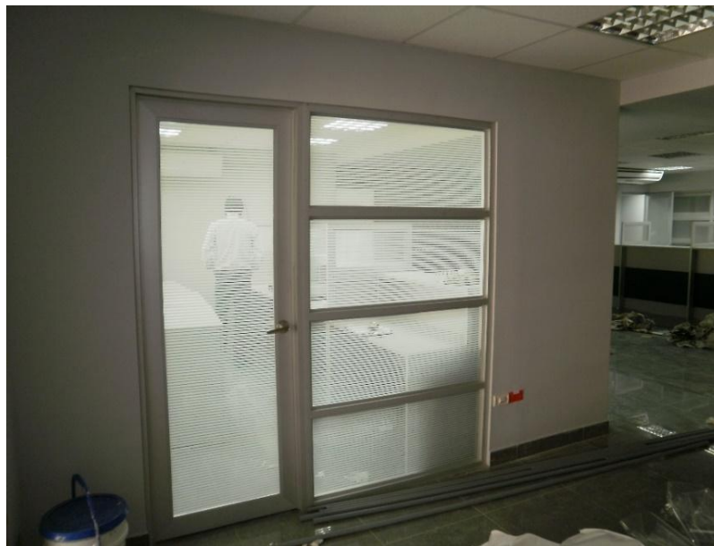
Imagen 04. Vista referencial tabiquería de aluminio y vidrio.
